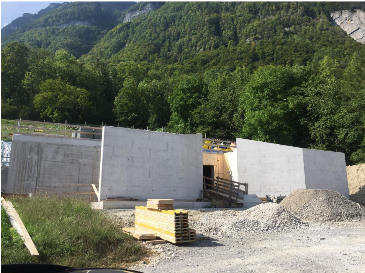
Eingangsbereich des neuen Reservoirs Aspe
