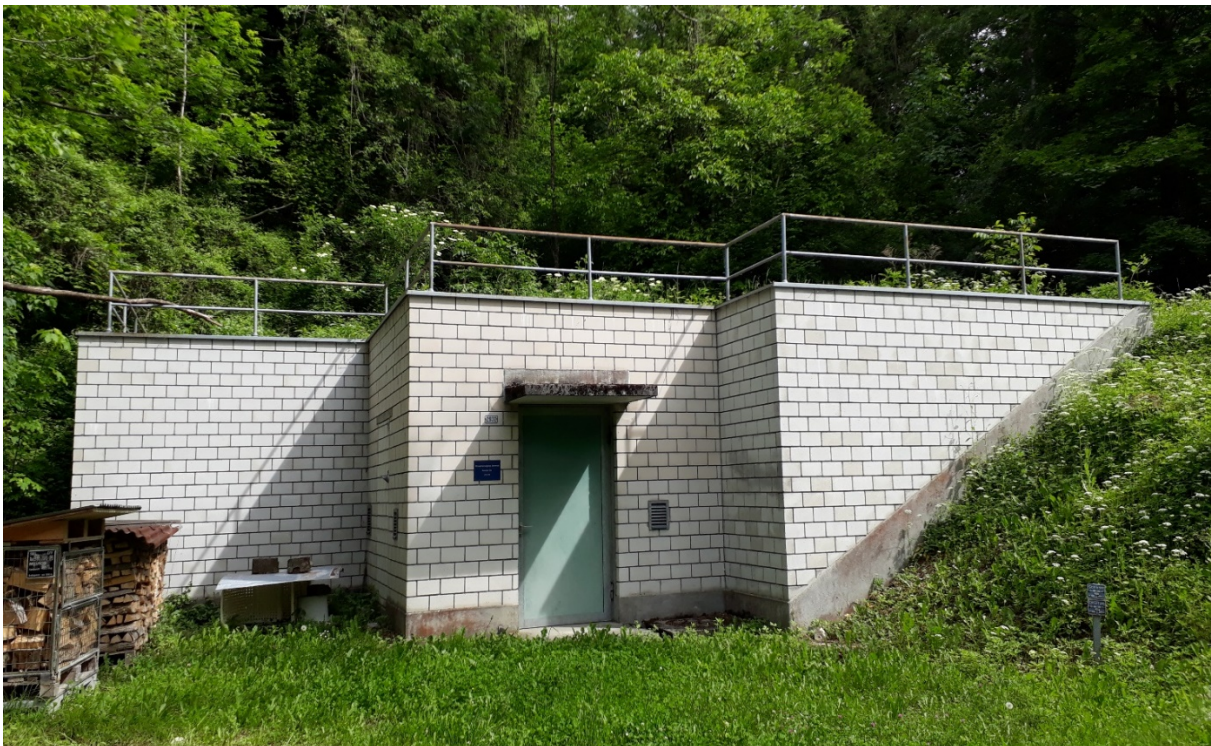
Bild: Reservoir „Rüti“, Sennwald
