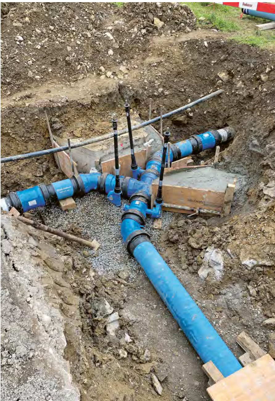
Klappeneinbau Umlegung Werdenberger Binnenkanal/Sägengasse
