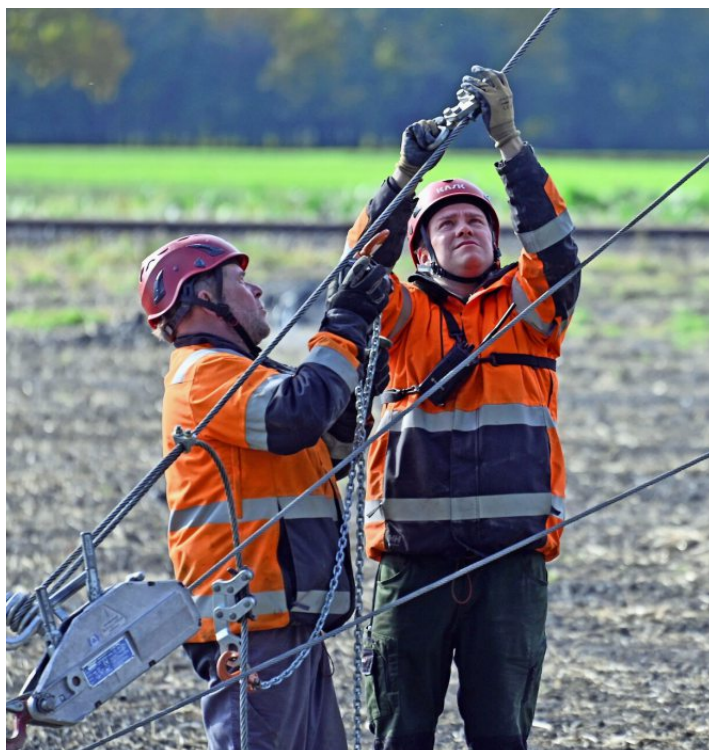
Der Mast wurde an mehreren Punkten mit Stahlseilen gesichert.
