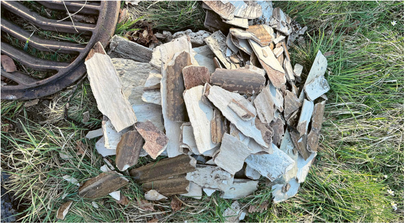
Kalkablagerungen von Leitungen an der Saxerbergstrasse
