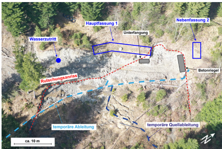
Abbildung 3: Situation der Quellfassungen Hübschewald mit den ausgeführten Sofortmassnahmen vom November bis Dezember 2023.
